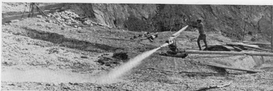
Symétain. — Chantier à abattage hydraulique.
